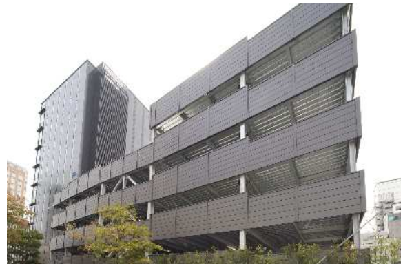
自走式立体駐車場
